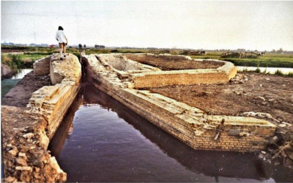
Marieke den Boer door haar vader gefotografeerd op de blootgelegde fundering van de Essemolen vóór de invulling en ombouw als picknickplaats voor recreanten, ca. 1992
